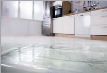
Ein abgerissener Schlauch oder eine defekte Dichtung: Schon ist der Raum geflutet ...
