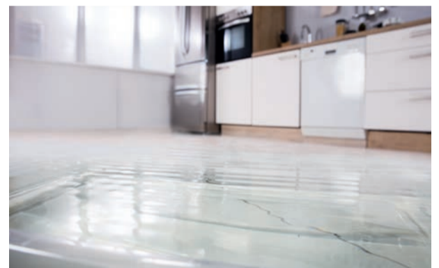
Ein abgerissener Schlauch oder eine defekte Dichtung – schon ist der Raum geflutet.
